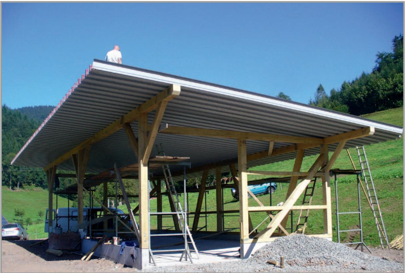
*hochtragfähiges Stahlblech 205er mit Vlies 1,25 mm stark*
