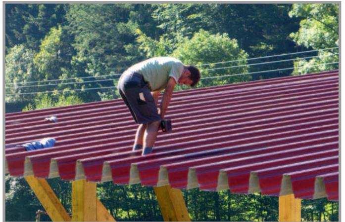
*hochtragfähiges Stahlbl. 205er mit Vlies 1,25 mm*
