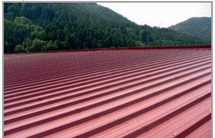
*Stahlblech 45 T mit Vlies u. Spezial-Lüfterfirstelement*
