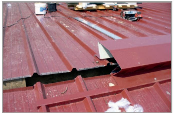
*firstseitig aufgeböteltes Stahlblech 45T vliesbeschichtet mit Spezial-Lüfterfirstelement*
