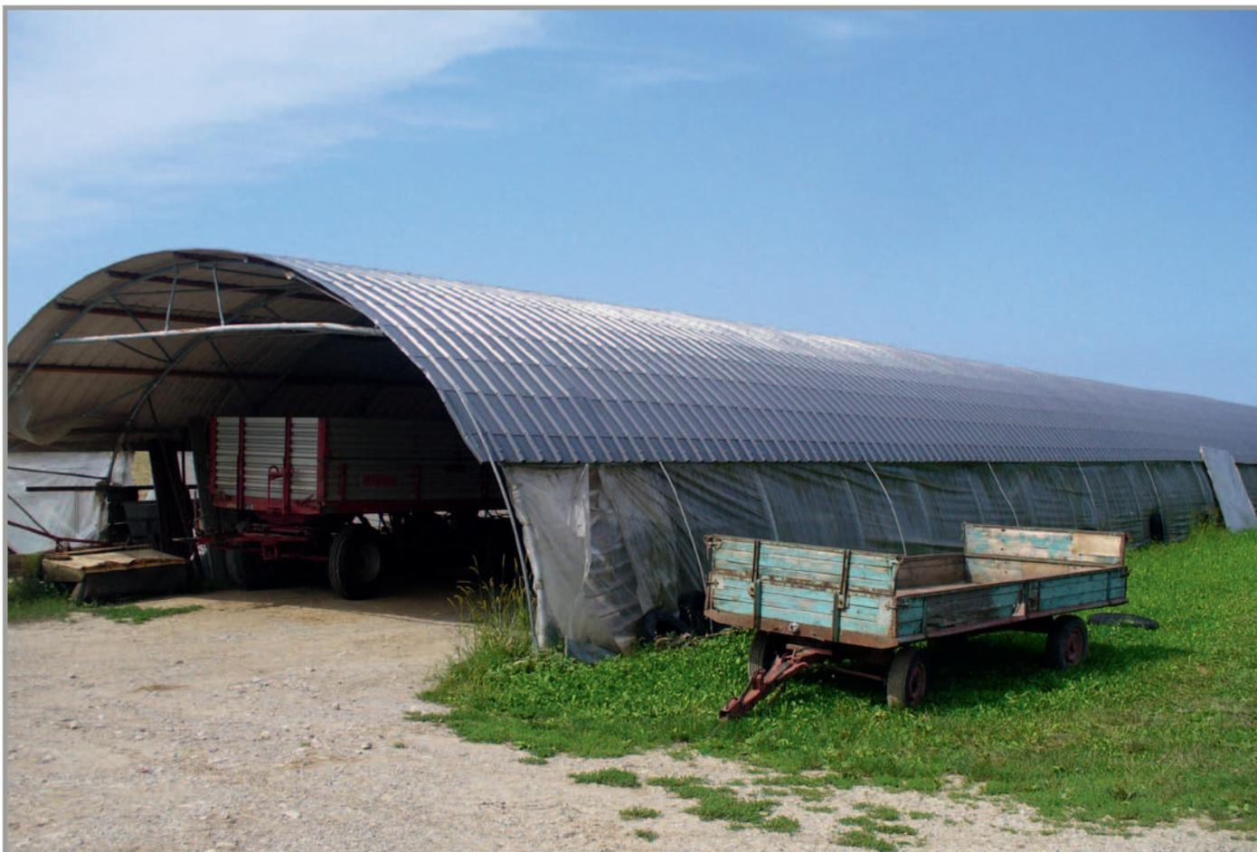
*bombiertes Stahlblech 36T RAL 7015*
