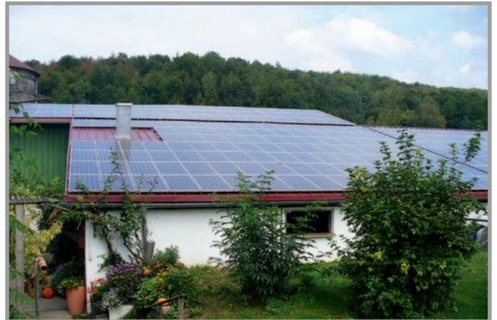
Sandwichelemente mit PV-Anlage
